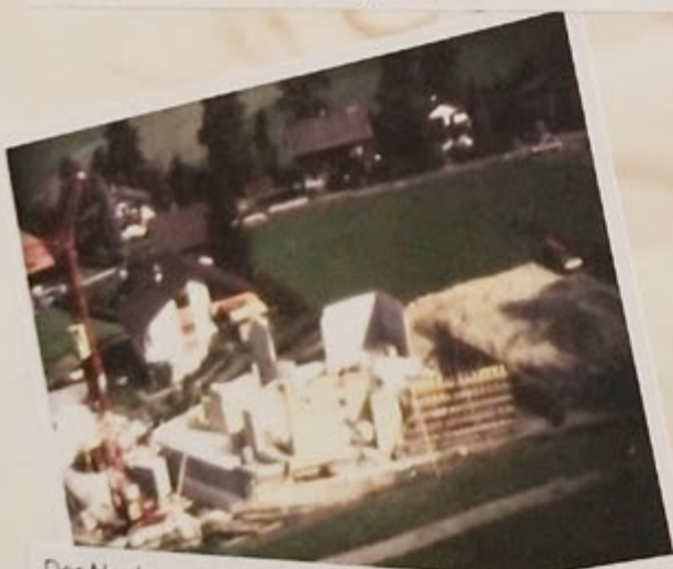
Der Neubau von 1983-1985 (Eröffnung Oktober 1985) prägte die heutige Gemeinde enorm. Jung und Alt halfen gemeinsam und gingen an finanzielle und körperliche Grenzen, um das Gebäude gemeinsam zu bauen. Der Bau brachte einige Schwierigkeiten mit sich, da der Boden sumpfig ist und so das Haus auf Pfähle gestellt werden musste. Der neu gekommene Prediger Ueli Röthlisberger, der Wurzeln am Ort hat, war ein Geschenk für die Bauarbeiten. Schliesslich kam er aus dem Holzbau.
