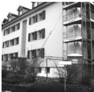
Sanierung an der Ankerstrasse 7
