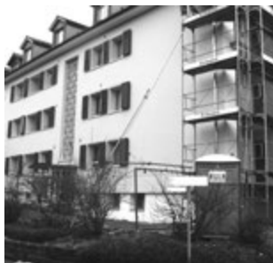
Sanierung an der Ankerstrasse 7
