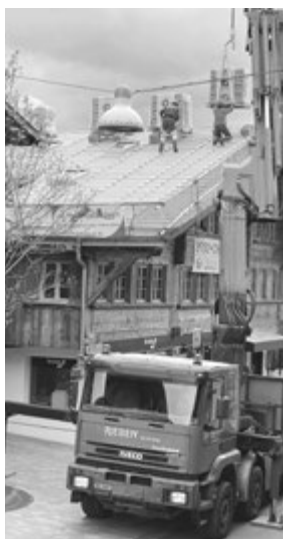
Neues Dach fürs Reinhardhaus.
